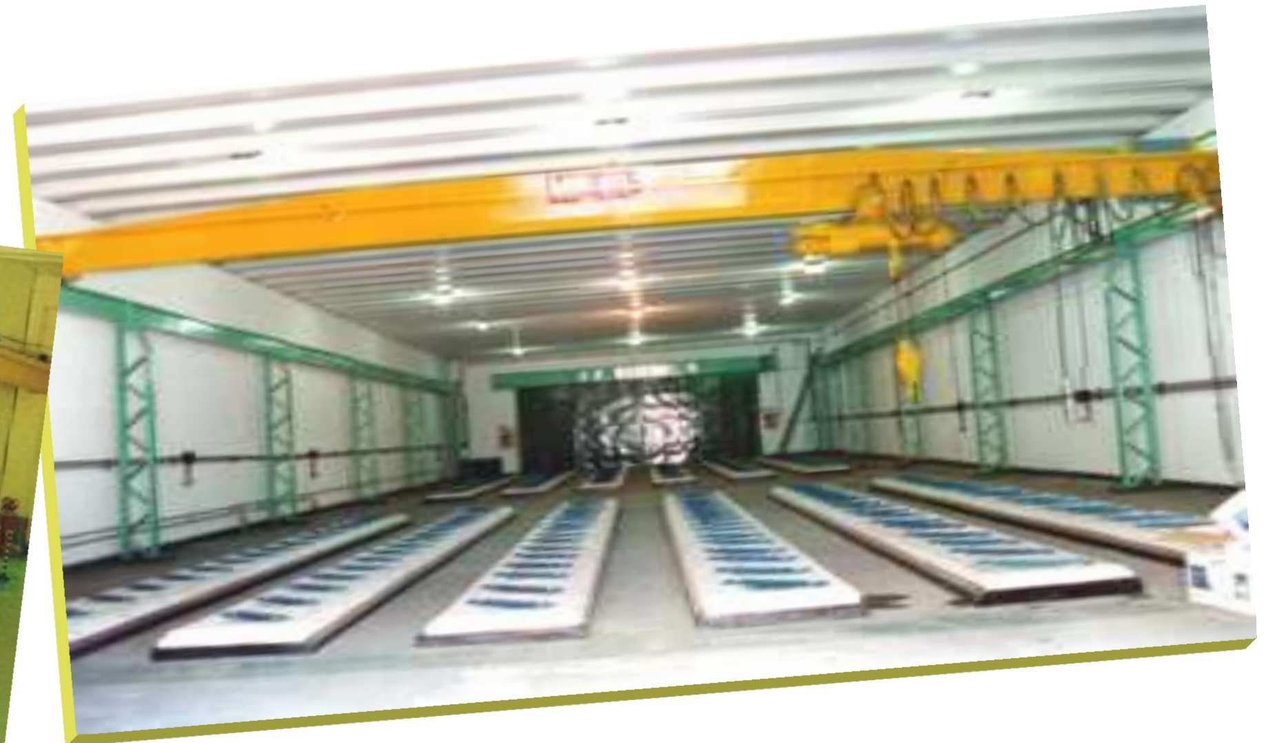
Almacenamiento de Elementos Combustibles de Reactores de Investigación Gastados
