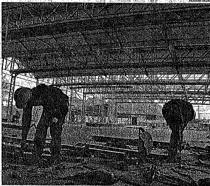
EN OBRA. 40 PERSONAS TRABAJAN POR DÍA. QUEDARÍA LISTO EN NOVIEMBRE.
