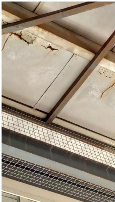
Canaleta deteriorada, viga celosía, correa C intermedia.
