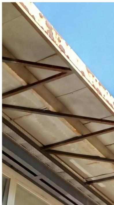
Correa “C” exterior, viga celosía y canaletas deterioradas.
