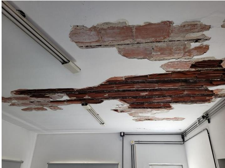
Foto: Estado de armaduras de viguetas.
