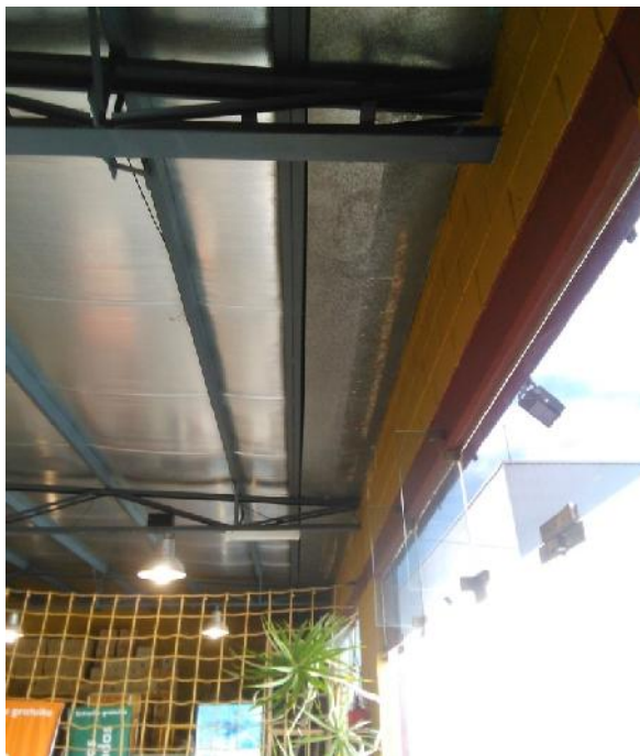
Imagen de la canaleta y sus apoyos.
