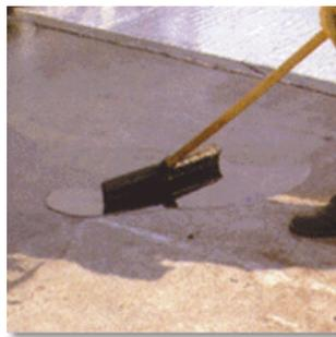
Se inicia la colocación de la membrana en los desagües, siguiendo hacia los puntos más altos del techo.
