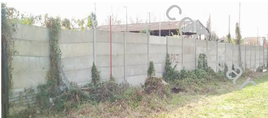
Imagen 1: Cerco premoldeado a retirar en predio 29 de Septiembre
