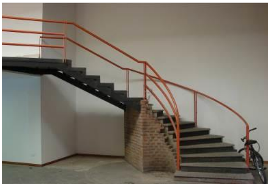
Escalera de acceso a sector Radio UNLa
