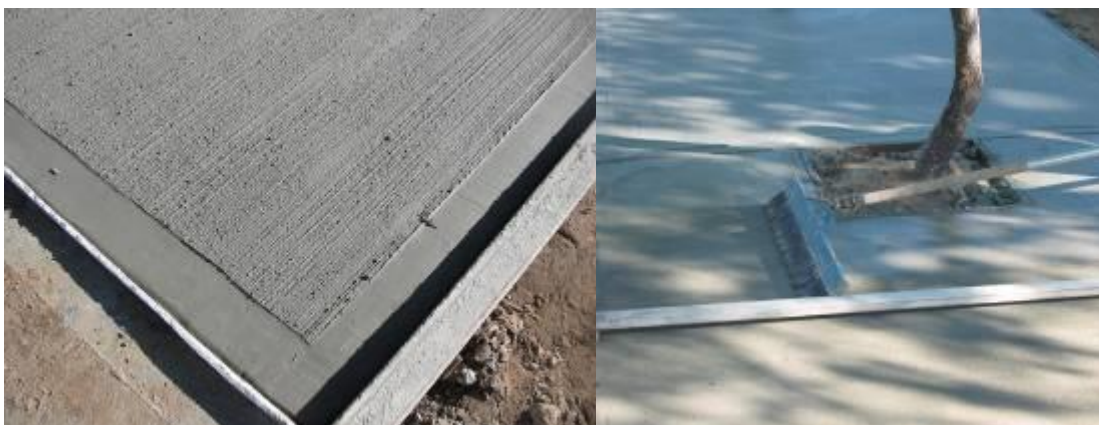
imágenes ilustrativas de terminación y ejecución del ítem
