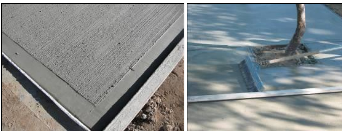
Imágenes ilustrativas de terminación y ejecución de la tarea.
