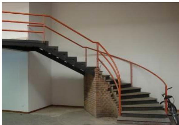
Escalera de acceso a sector Radio UNLa
